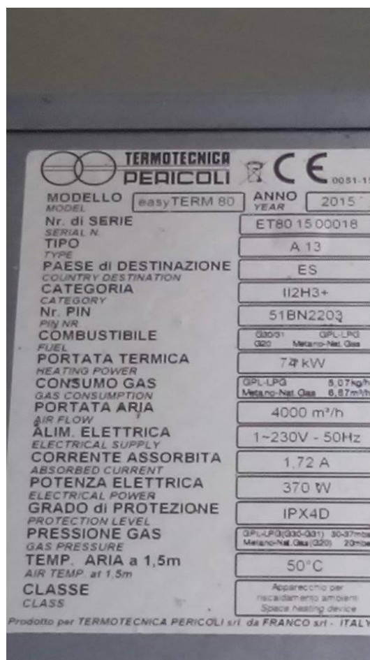
Figura 2.5 – Especificações técnicas dos aquecedores dos pavilhões de produção
